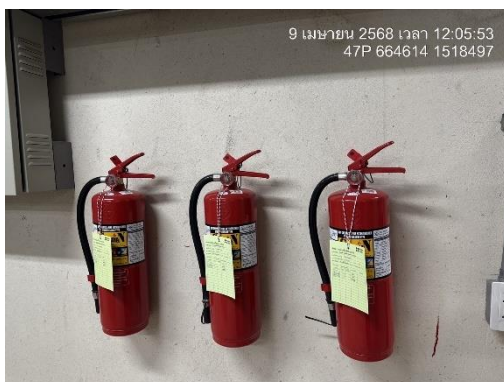
รูปที่ 35 ถังดับเพลิงแบบมือถือเป็นแบบผงเคมีแห้ง
