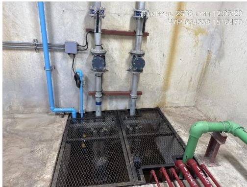
รูปที่ 31 บ่อน้ำสำรองเพื่อใช้ดับเพลิง
