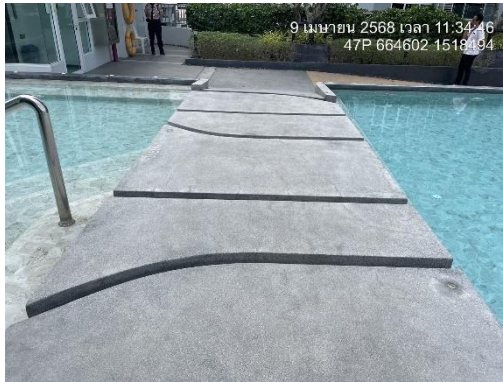
รูปที่ 82 แถบกันลื่นไว้บริเวณบันไดสำหรับขึ้นจากสระว่ายน้ำ
