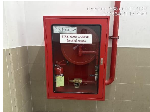
รูปที่ 34 ตู้เก็บสายฉีดน้ำดับเพลิง
