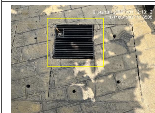
รูปที่ 19 ตะแกรงดักขยะรางระบายน้ำ
