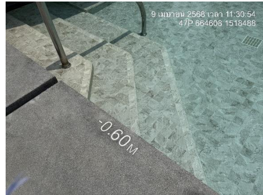
รูปที่ 82 แถบกันลื่นไว้บริเวณบันไดสำหรับขึ้นจากสระว่ายน้ำ
