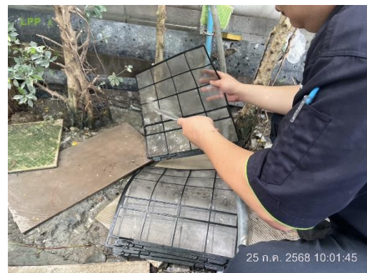
รูปที่ 70 การล้างแผ่นกรองอากาศของเครื่องปรับอากาศ
