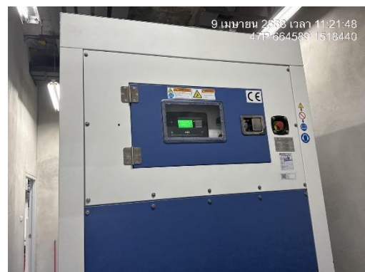
รูปที่ 61 เครื่องไฟฟ้าสำรอง
