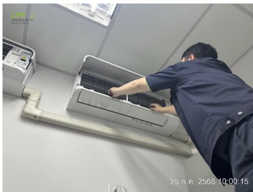
รูปที่ 70 การล้างแผ่นกรองอากาศของเครื่องปรับอากาศ
