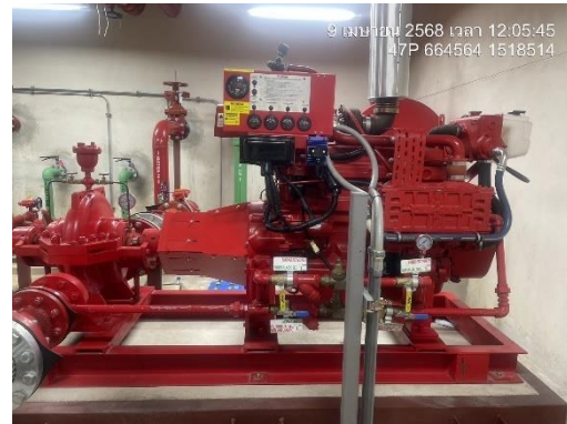
รูปที่ 32 ระบบจ่ายน้ำดับเพลิง
